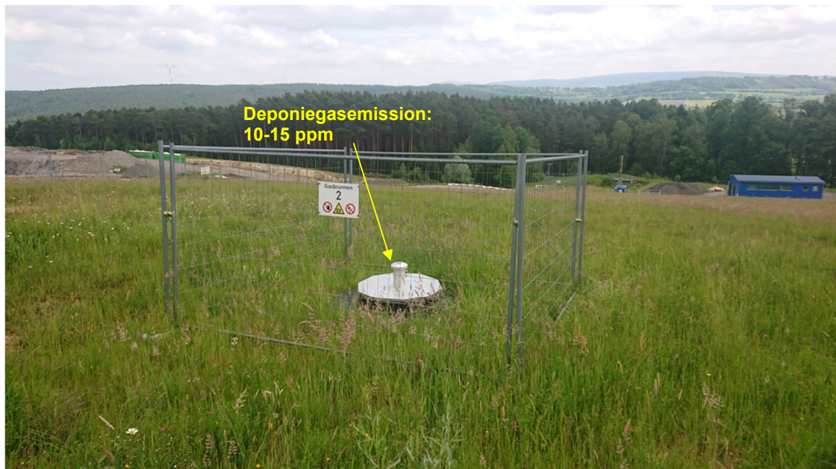
Bild 2: südlicher Deponiebereich, Gasbrunnen 2
