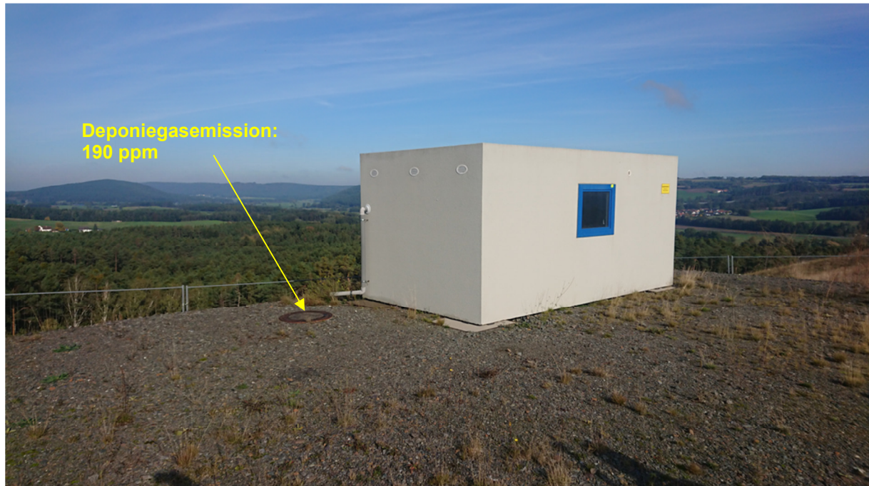
Bild 1: Gasunterstation GUS B – Kondensatschacht mit Emissionen
