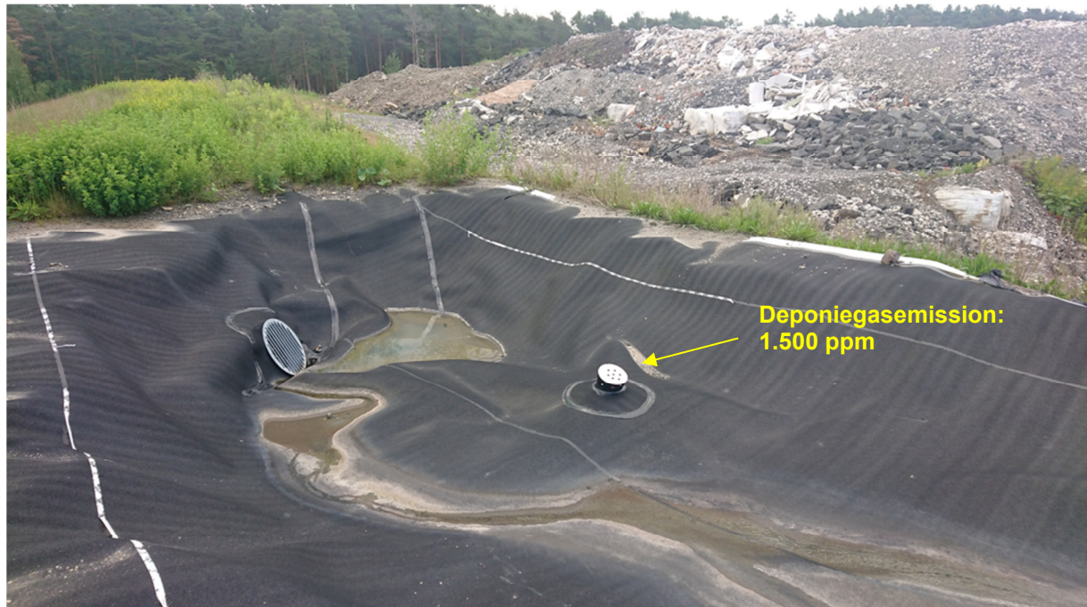
Bild 1: Deponietop - Oberflächenwassersammelbecken
