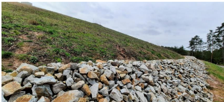
Bild: Westböschung mit Entwässerungswall
