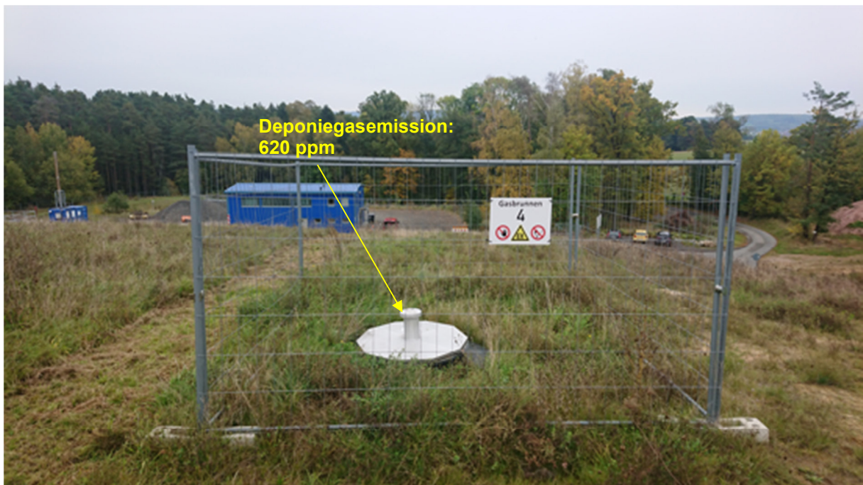
Bild 2: südlicher Deponiebereich, Gasbrunnen 4
