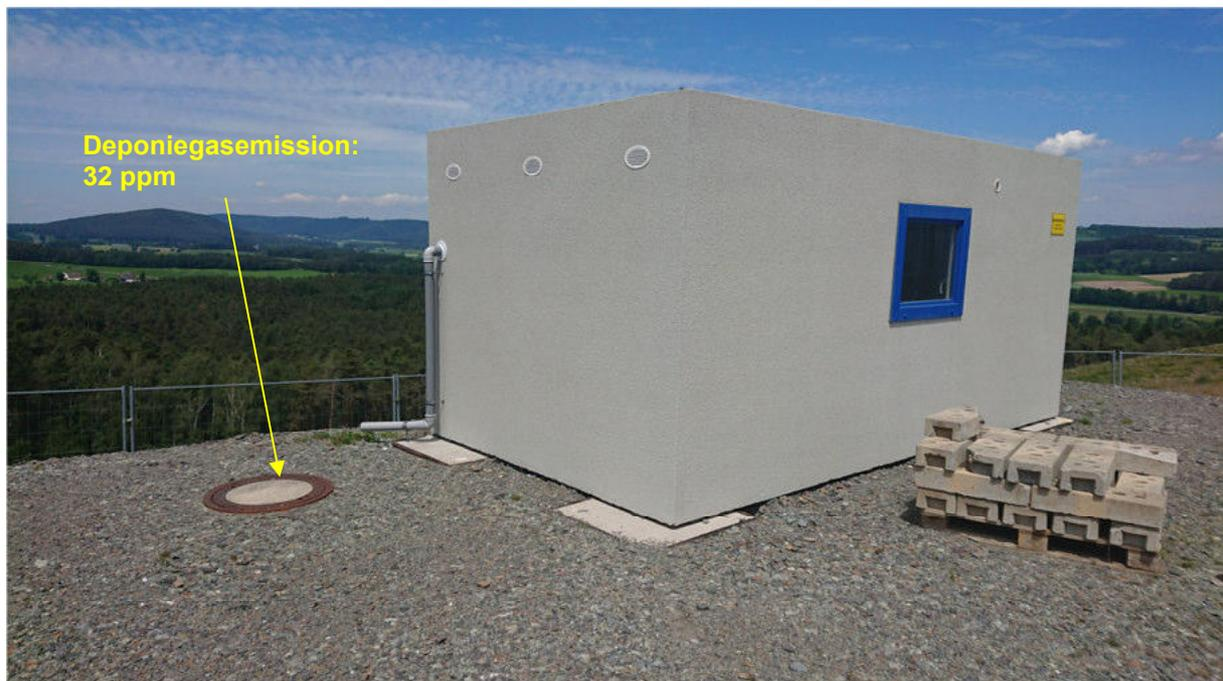
**Bild 2:** Gasunterstation GUS B mit Kondensatschacht
