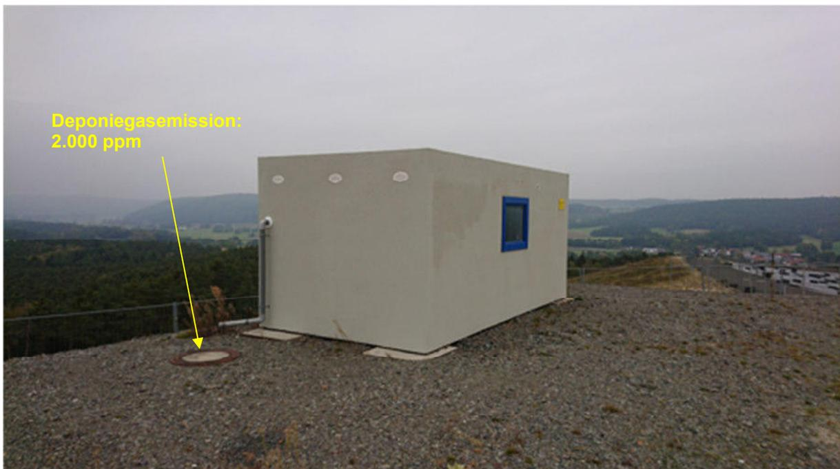
**Bild 2:** Gasunterstation GUS B mit Kondensatschacht
